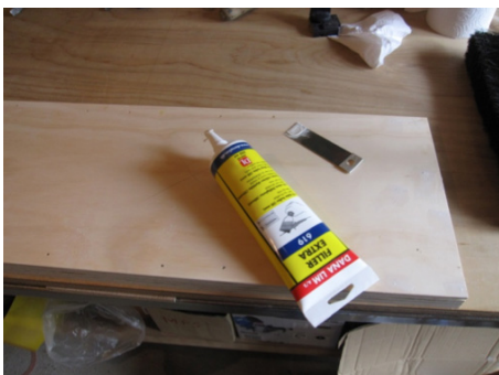
Ca. 100 huller fra sømpistol pr. plade spartles
